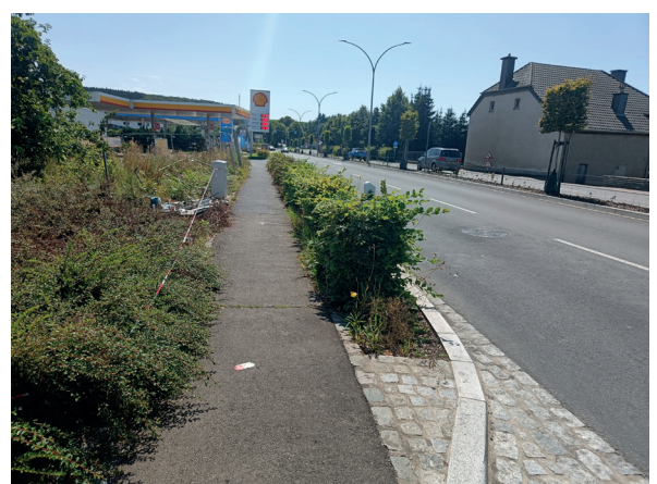
Abb.5: Ortsbild entlang der RN15
